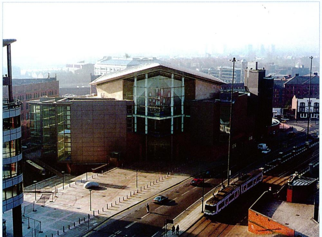
● 英国曼彻斯特 支承在3.5Hz隔振系统上的Bridgewater音乐厅
